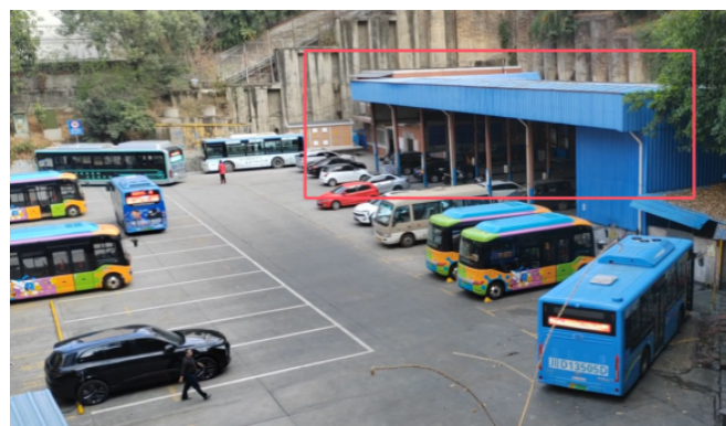
图26 光伏车棚与周围建筑结合（a）
