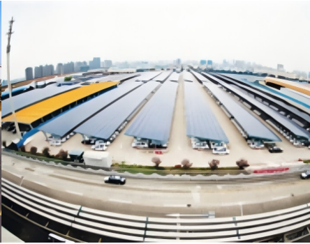
图4 南京市高速公路站区光伏车棚
